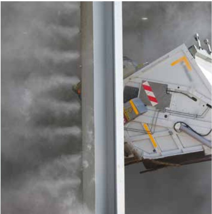
FESTINSTALLIERTE DÜSENLEITUNGEN ▪ Staubbindung an Aufgabestation einer Müllverbrennungsanlage
