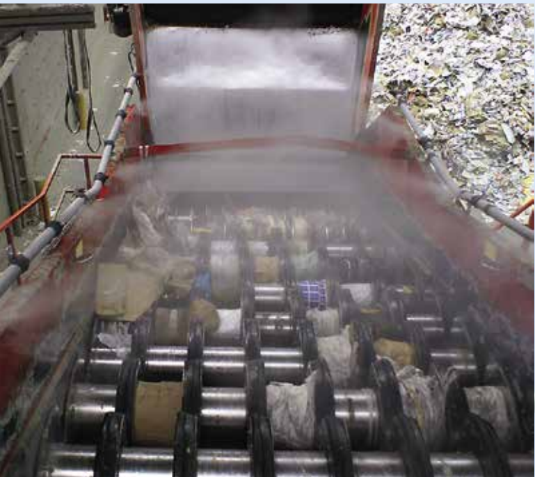
FESTINSTALLIERTE STAUBBINDEANLAGE ▪ Staubbindung an einer Papier-Recycling-Anlage
